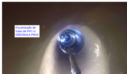
DETALLE INTERIOR DEL TUBO DE PVC DN250 DEL POZO-SONDEO DE CAPTACIÓN
