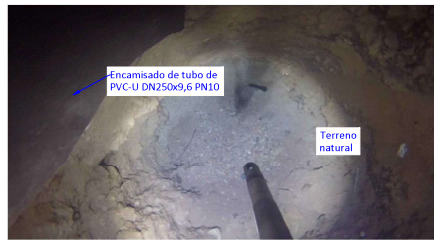
DETALLE INTERIOR DEL FONDO DEL POZO-SONDEO DE CAPTACIÓN
