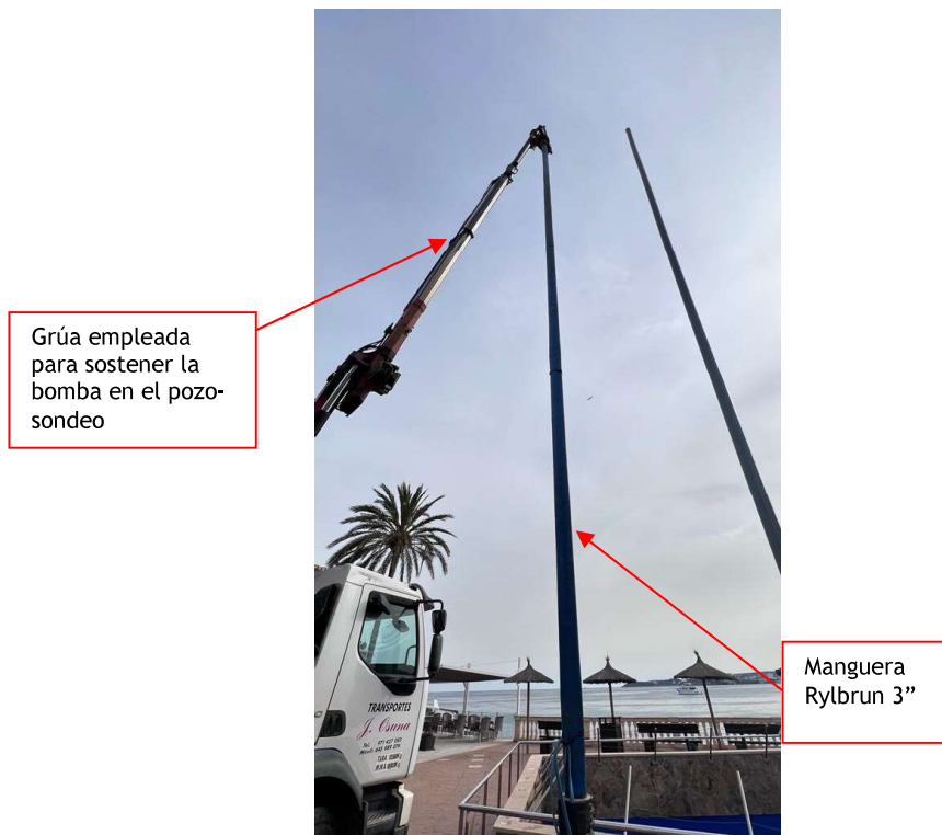
Figura 2-20. Detalle de la grúa empleada para sostener la bomba
